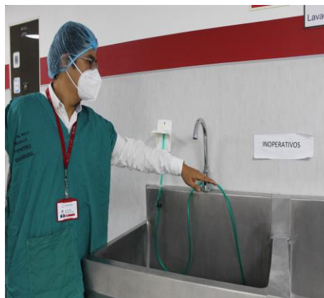
Fotografía n.º 15 Puerta de la sala C no cierra herméticamente por problemas en los topes
