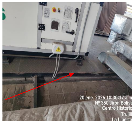
Fotografías n.º 1 y 2 No existencia de muro bajo perimetral de H= 1.00 ml (lado izquierdo)
