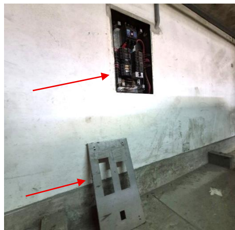
Fotografías n.ºs 8 y 9 Conexiones eléctricas deficientes en el ambiente de Cuarto de Máquinas
