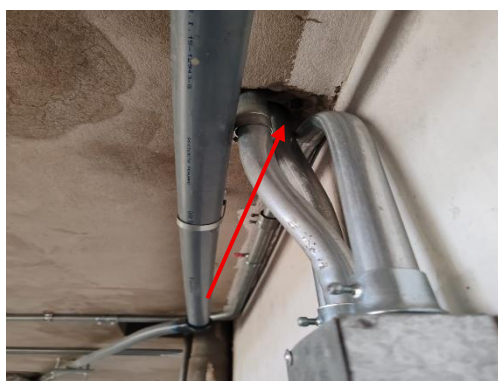
Fotografías n.ºs 5 y 6 Perforaciones realizadas para los bajantes de luz y ventilación
