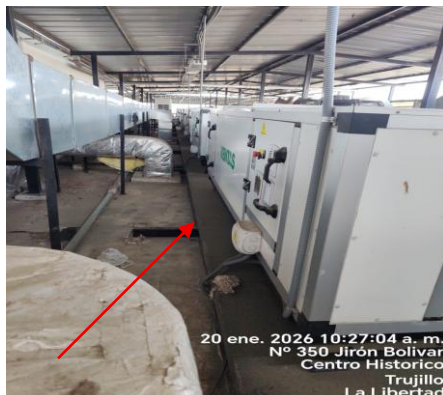
Fotografías n.º 1 y 2 No existencia de muro bajo perimetral de H= 1.00 ml (lado izquierdo)
