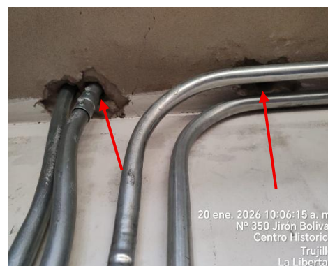
Fotografías n.ºs 5 y 6 Perforaciones realizadas para los bajantes de luz y ventilación
